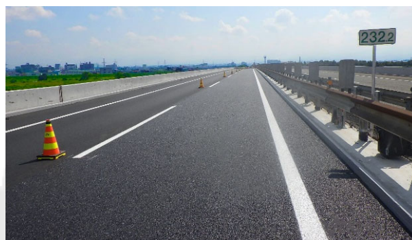
北陸自動車道(特定更新等) 富山管内舗装補修工事(2020年度)
