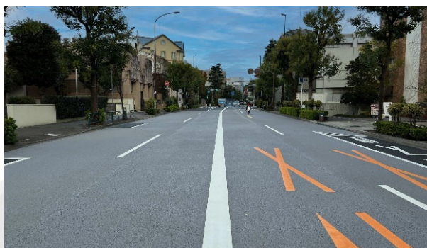
路面補修工事 (4二の9・遮熱性舗装)
