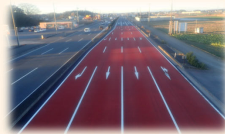
R2国分寺出張所管内路面補修工事 ＜高強度アスファルト混合物「ストロングファルト」施工＞
