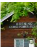
ヒートポンプの動力の一部を賅っている水力発電設備
