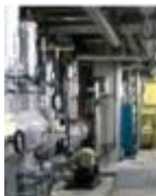
地中熱や温泉排熱を空調や給湯の熱源にするヒートポンプ設備
