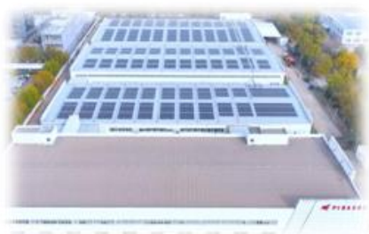
天津工場太陽光パネル発電
