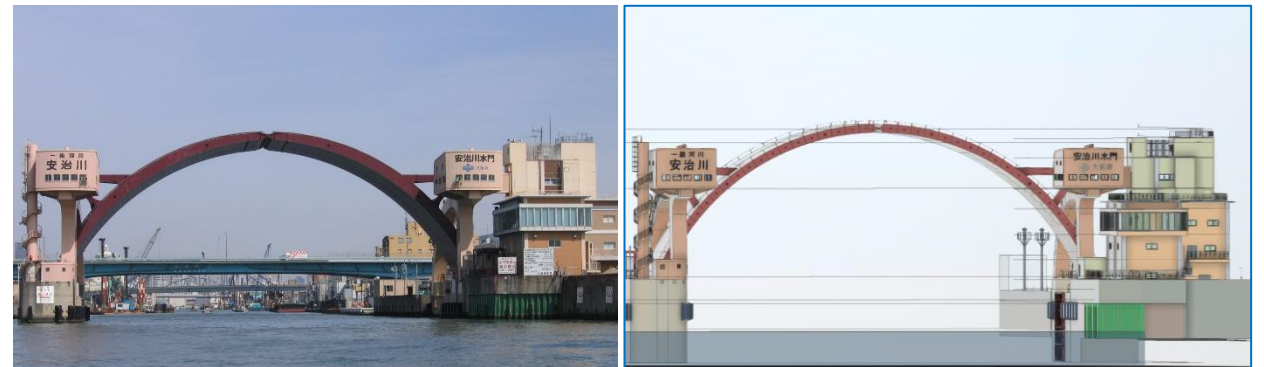
安治川水門（大阪府ホームページより）
