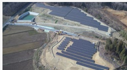
S-28 茨城常陸大宮 太陽光発電所
