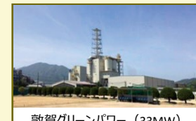
敦賀グリーンパワー (33MW)
