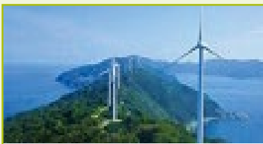
三崎ウインド・パワー (20MW)
