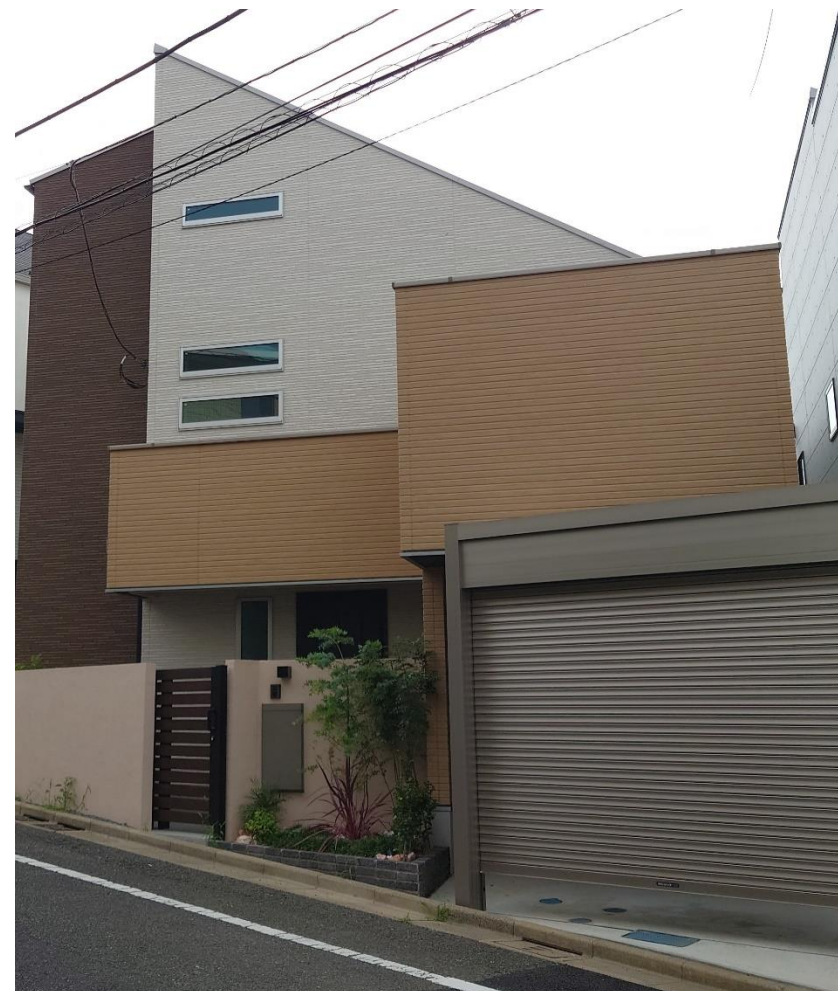
木造3階建住宅（世田谷区下馬）
