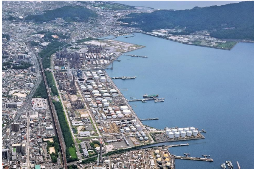
HEFA-SAF製造設備の建設予定地である徳山事業所の外観
