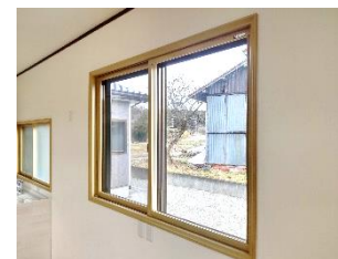
内窓の設置事例
