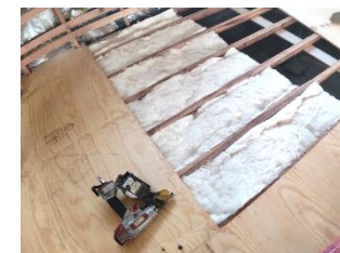
断熱材の設置事例
