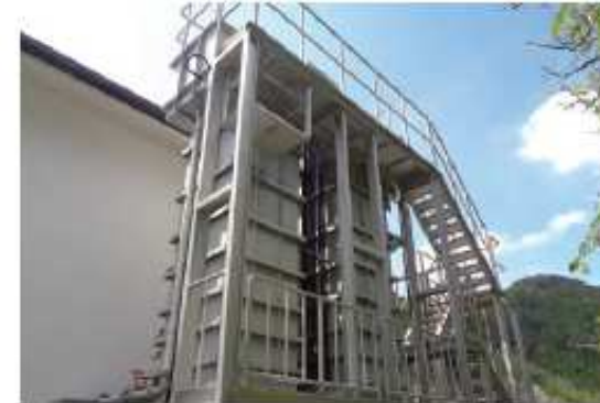
東京都小笠原村沖村浄水場(令和2年稼働)
