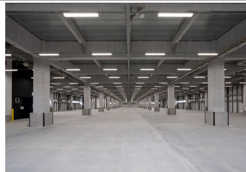
▲ 最新の技術により、柱の少ない大空間が誕生しました。
