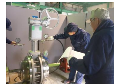
販売しているLNG用バルブ
