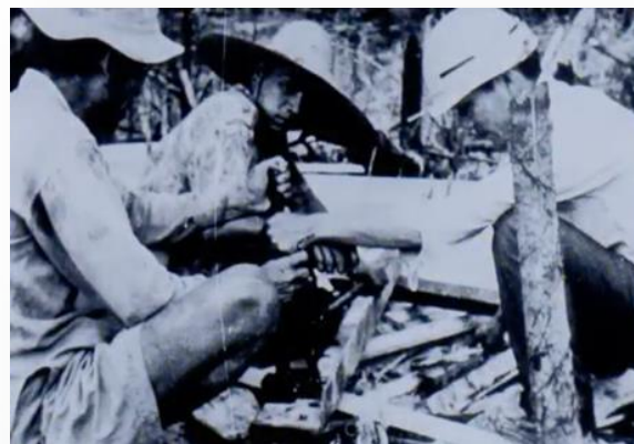
1961年 ベトナム戦争中に 729基の鉄塔を建設
