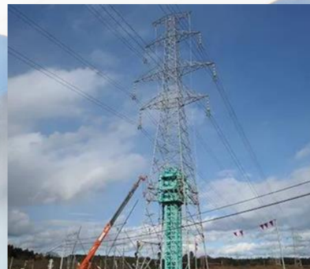
2016年 鉄塔高上げ装置「エナーク160」を開発、 特許権を取得
