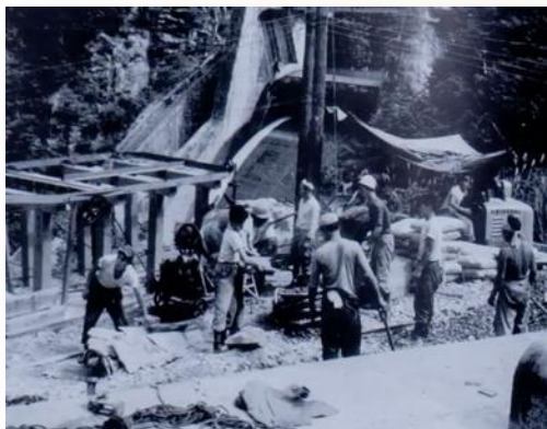
1963年 黒部ダム 電気工事完工
