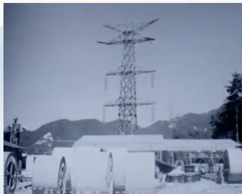
1988年 国内初100万ボルト送電工事受注
