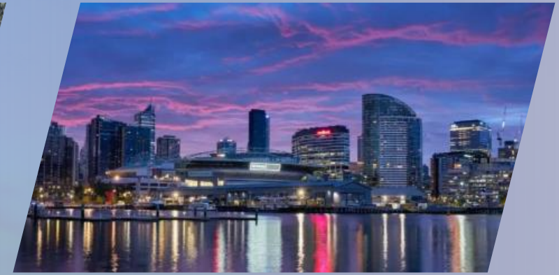
設備事業 (内線工事事業)
