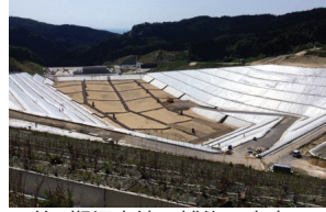
第1期埋立地の補修工事了
