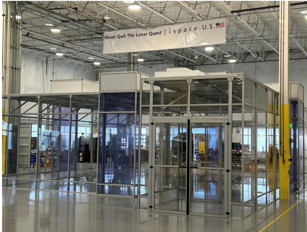
米国法人拠点で設置中のクリーンルーム
