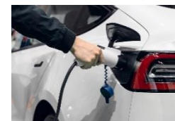
EV充電ステーション
