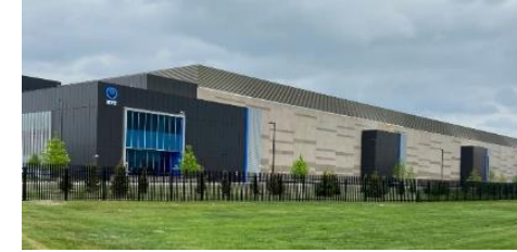
米国シカゴのデータセンター
