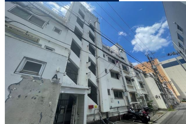
施工後 国有文化財
