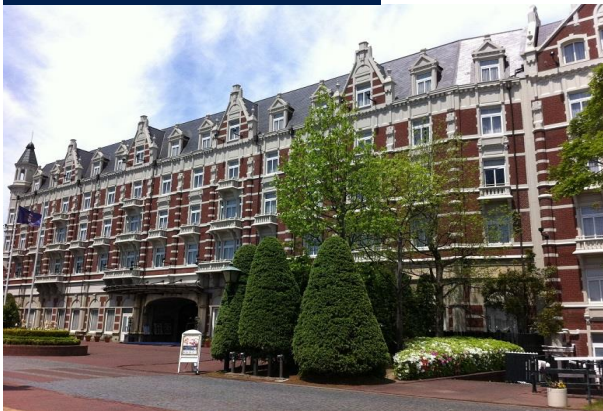
施工後 テーマパーク
