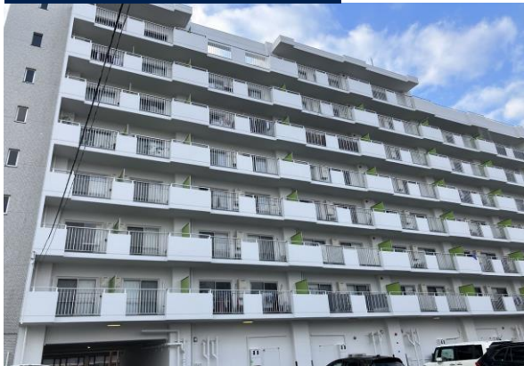
施工後 集合住宅
