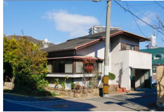
施工前 戸建て住宅
