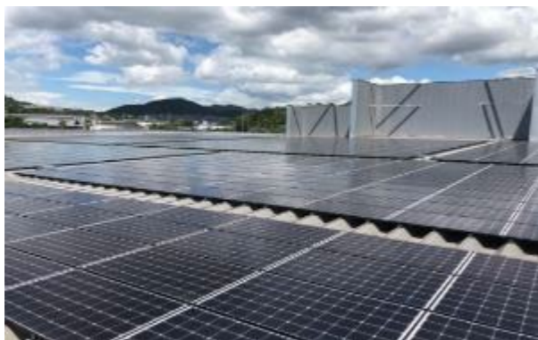
DCM店舗屋上
