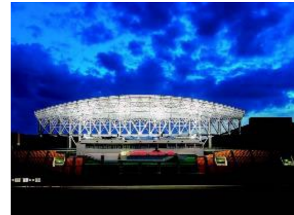
膜構造天井(陸上競技場)
