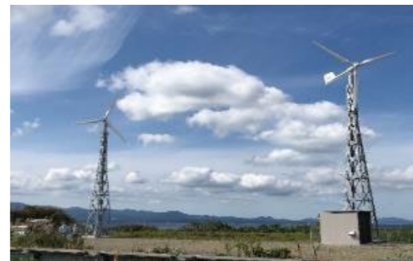
発電量10kw/基(青森県 野辺地明前)
