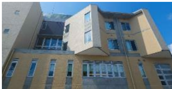
外壁工事(病院)
