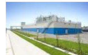
排水処理システム
