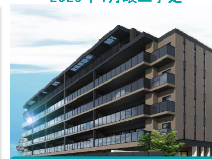
トラスト博多南駅レジデンス (福岡県福岡市)
