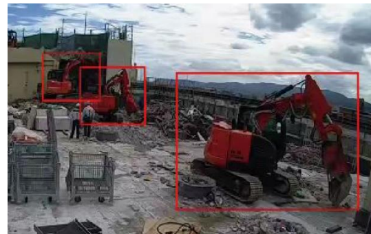
(事例) 解体重機の稼働率監視 解析結果を重機の追加手配検討に活用
