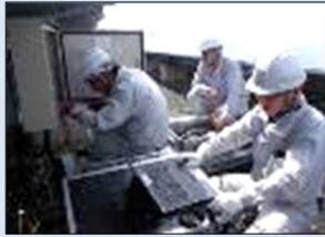
発電所の検査サービス
