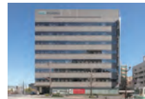
熊本イーストフロントビル
