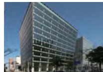
博多FDビジネスセンター
