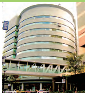
キャナルシティ・ ビジネスセンタービル
