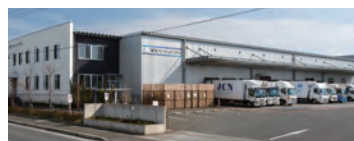
鳥栖ロジスティクスセンター
