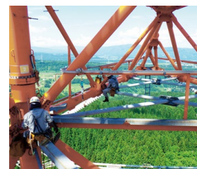
▲架空送電線設備保守業務委託工事
