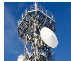
▲防災行政無線工事
