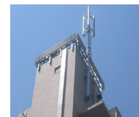
▲移動体通信工事
