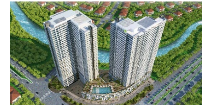
▲サンライズシティビュウ (電気・空調衛生設備工事)
