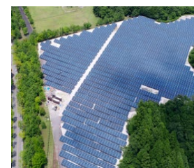
▲太陽光発電設備工事
