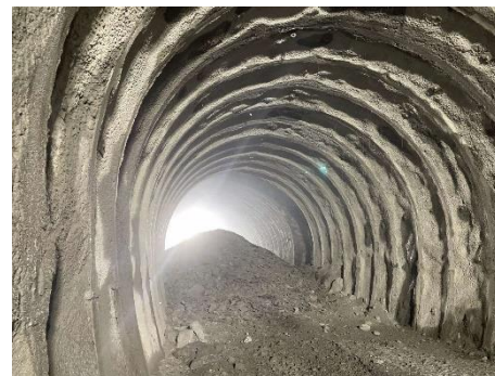
南アルプストネル (長野工区) 先進坑貫通 (除山非常口～釜沢非常口)
