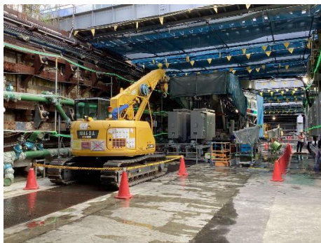
名古屋駅 (中央東工区) 地中連壁工 (掘削)
