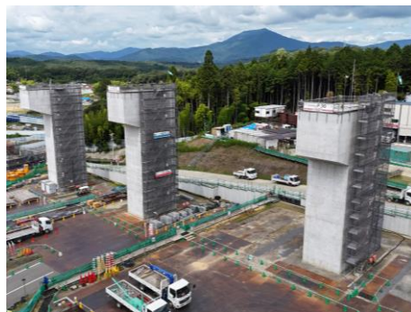
岐阜県駅 (仮称) 回送線橋脚工
