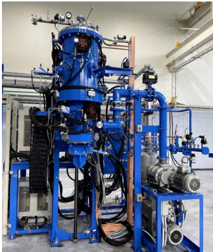
電池関連設備
