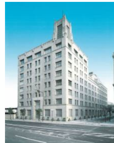
神戸本社 神港ビル
