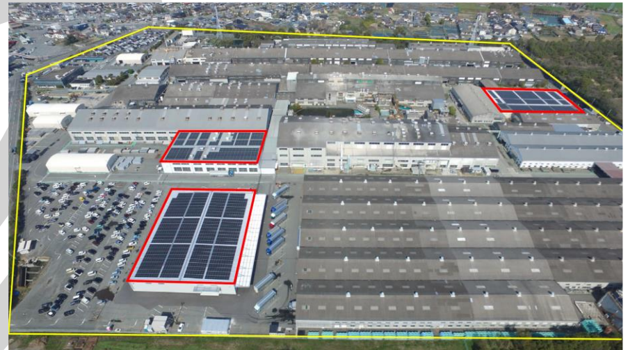
太陽光発電設備（不二ライトメタル上空） ※黄枠：敷地、赤枠：発電設備
