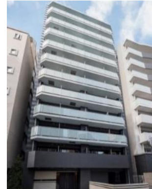
マンション施工事例
