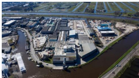
Gouda生産拠点 / 本社 (定形・不定形耐火物)
