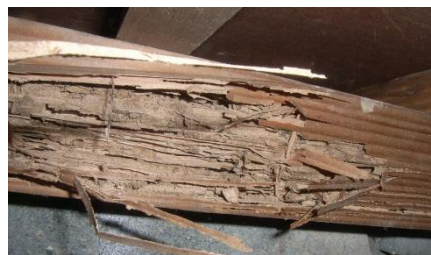
白蟻被害により耐力が低下した束柱(左)、大引き(右)
