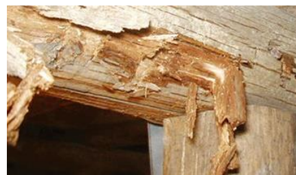
湿気被害により耐力が低下した接合部(左)、大引き(右)
