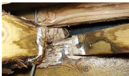
湿気被害により耐力が低下した接合部(左)、大引き(右)
