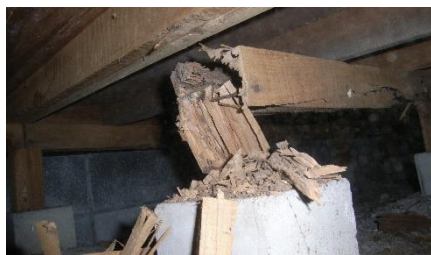
白蟻被害により耐力が低下した束柱(左)、大引き(右)
