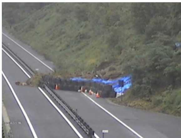
▲応急復旧作業前
