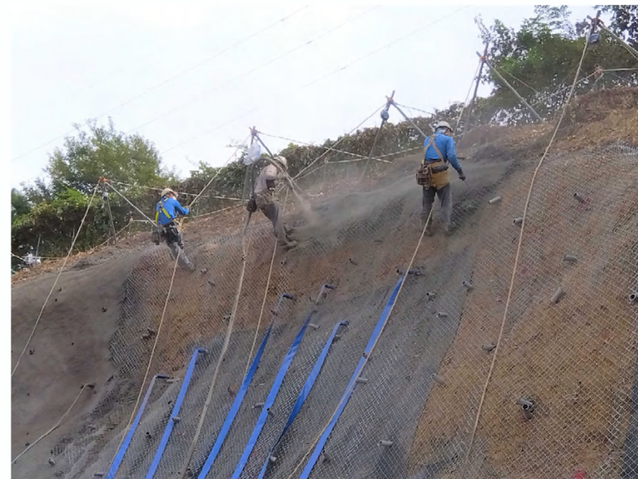
▲モルタル吹付状況（日特建設(株) 施工）
