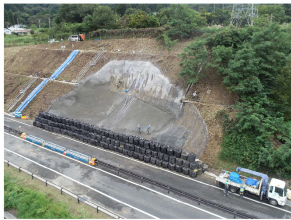
▲応急復旧作業状況
