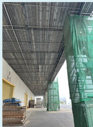
埠頭工事現場(吊り足場)
