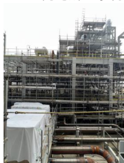
バイオマス発電所工事現場
