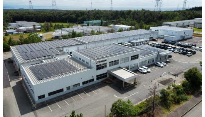
既存工場棟（太陽光パネル設置）
