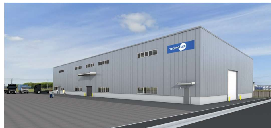
▲ 建設中の北海道工場(イメージ)
