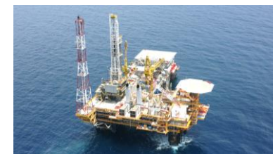
▲マレーシア追加開発プロジェクト
