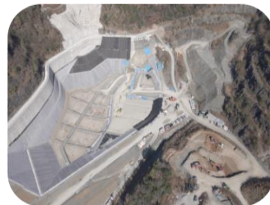
2022年2月 稼働開始 管理型最終処分場 (奥山の杜クリーンセンター)
