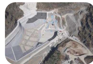
奥山の杜CC（最終処分場）
