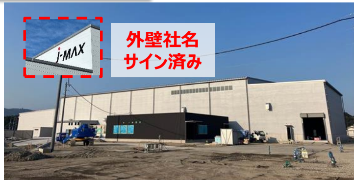
工場棟の外装、外壁および排水、受電の整備
