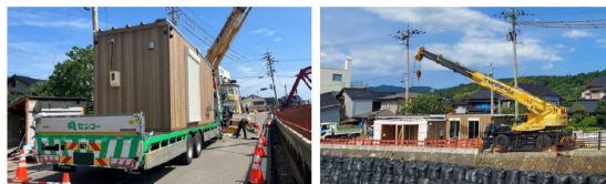
トラックで現地に搬送されたモクタスキューブ
