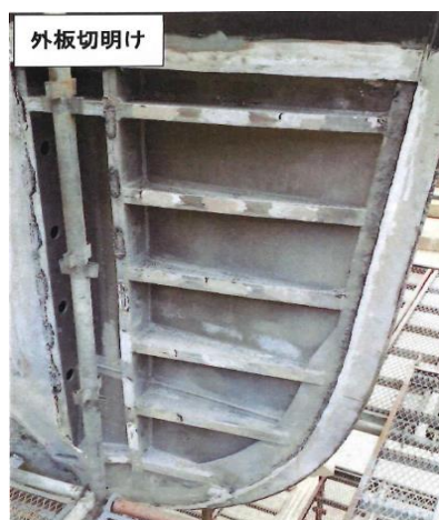
【図4：船首部分の右舷側の外板を外した内部構造の様子】
