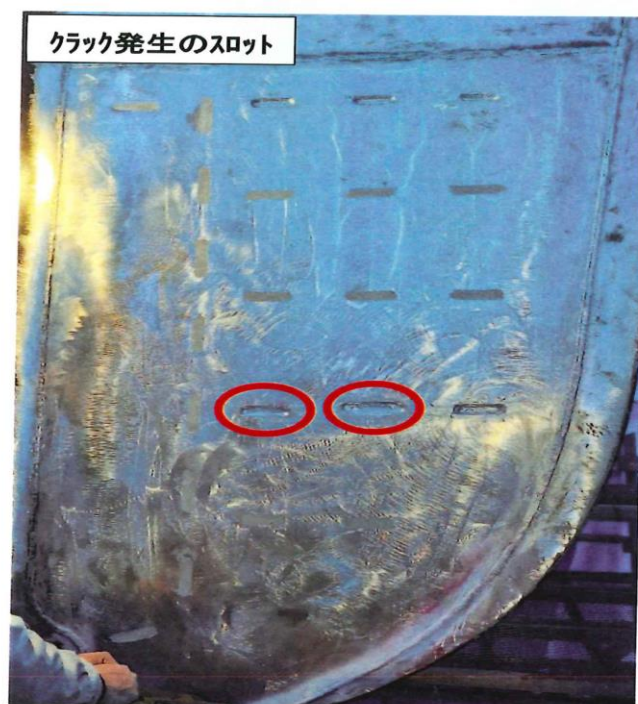
【図12：2024年1月に船首右舷側外板のスロット溶接部分に確認されたクラックの発生箇所】
