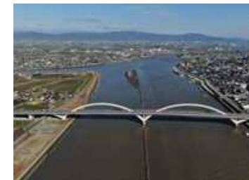
有明筑後川大橋
