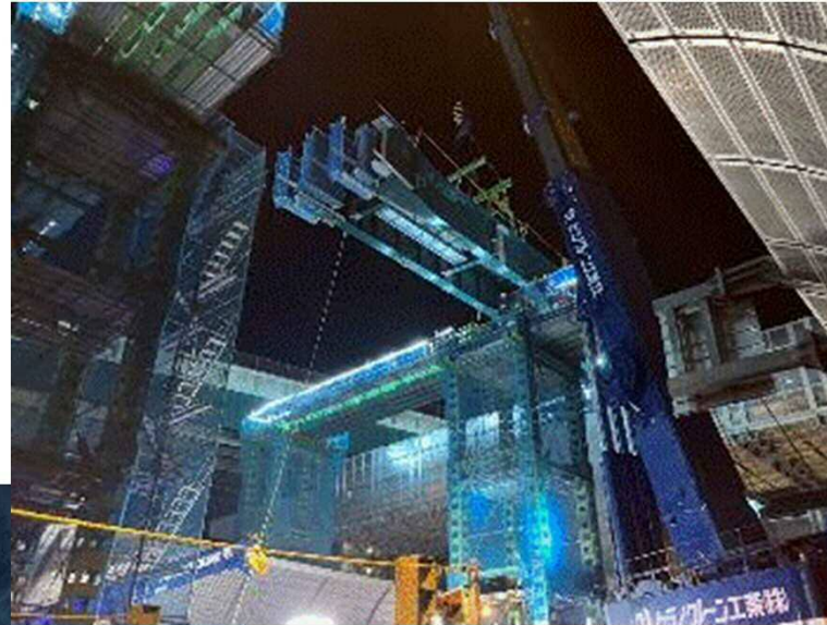
(大型クレーンを用いた 大ブロック架設の様子)
