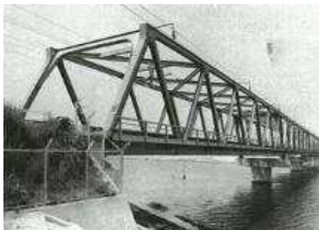
東海道新幹線江川橋梁
