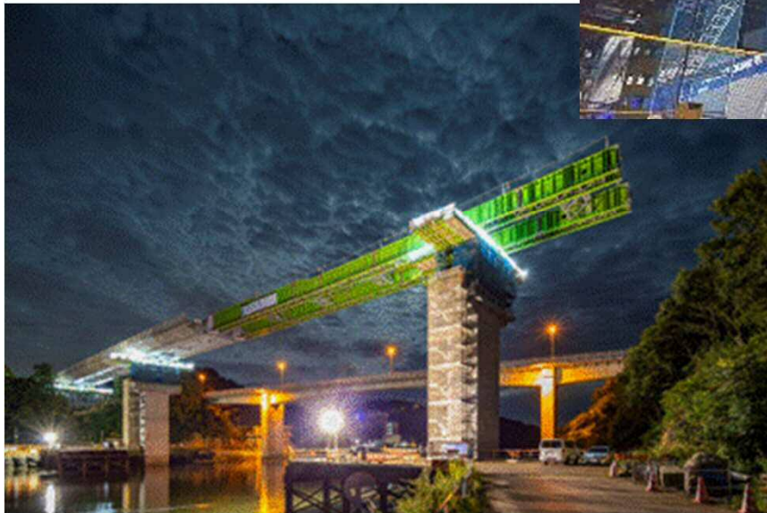
(手延べ機を用いた送り出し架設の様子)
