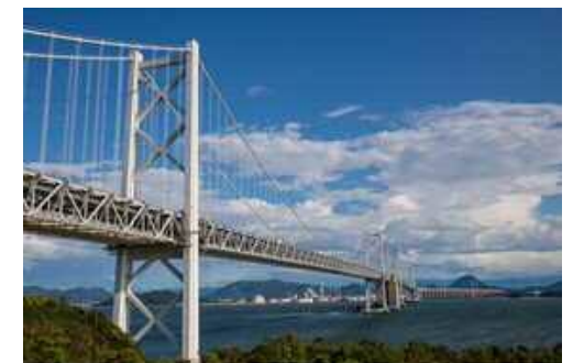
北備讃瀬戸大橋・南備讃瀬戸大橋
