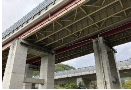
中央自動車道(特定更新等) 中野橋床版取替工事(2023年度) 中日本高速道路株式会社 富士ピー・エス・宮地エンジニアリングJV
