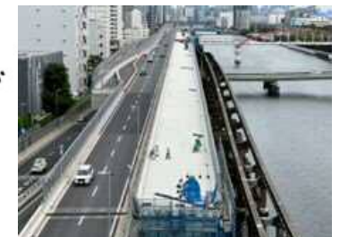
高速1号羽田線(東品川棧橋・鮫洲埋立部)更新工事 首都高速道路株式会社 大林・清水・三井住友・東亜・青木あすなる・ 川田・東骨・MMB・宮地異工種JV
