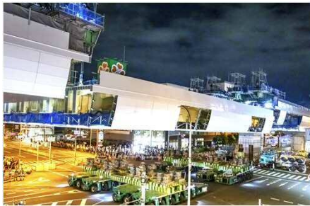
喜連瓜破大規模更新工事 阪神高速道路株式会社 大成・富士ピー・エス・MMB異工種JV
