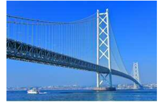
明石海峡大橋
