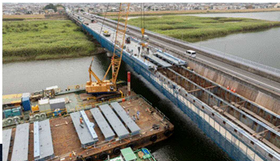
明石高砂線 相生橋上部工拡幅工事 兵庫県
