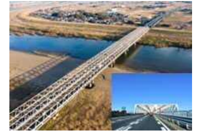
東北自動車道 利根川橋耐震補強工事 東日本高速道路株式会社 エム・エムブリッジ株式会社・鉄建建設株式会社
