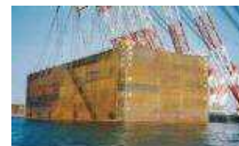
南本牧鋼製ケーソン
