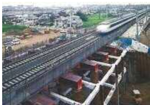
東海道新幹線箕輪架道橋
