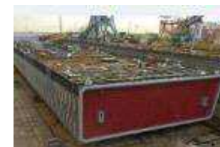
東京港海の森トンネル沈埋函
