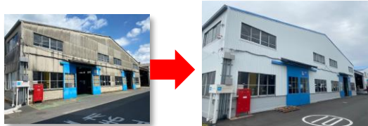
改修工事を行ったBXティアールの工場棟(右)
