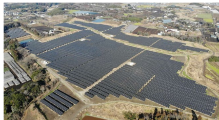
袖ヶ浦太陽光発電所
