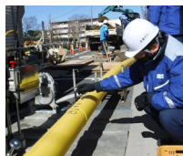
腐食や地震に強い PE管※1への入替
