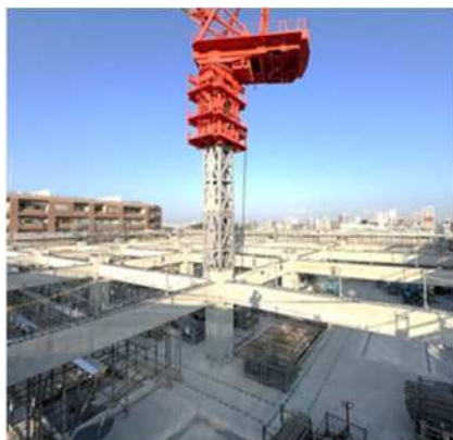
躯体工事施工中
