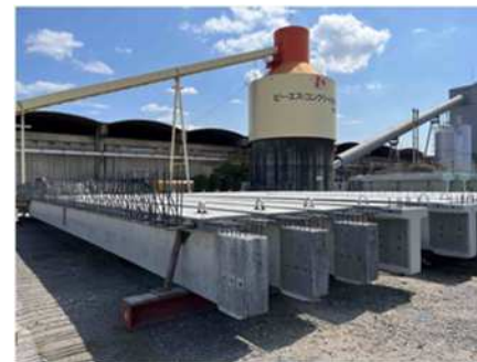
SLPCを用いたPC桁（製作工場ヤード）
