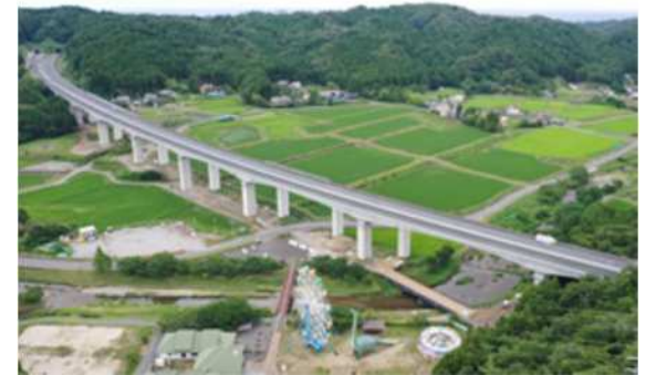
常磐自動車道大久川橋
