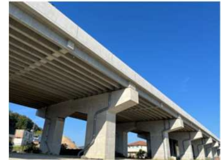
SLPCを用いた橋梁（完成）
