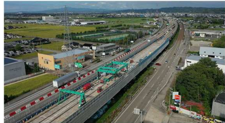
低空頭タイプ 床版架設機の施工状況
