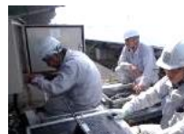
発電所の検査サービス
