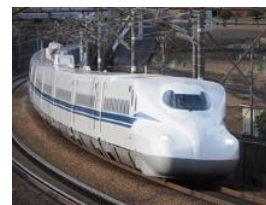
鉄道架線・電線など インフラ設備
