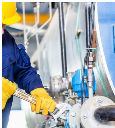
プロセスエンジニアリング事業 定期点検
