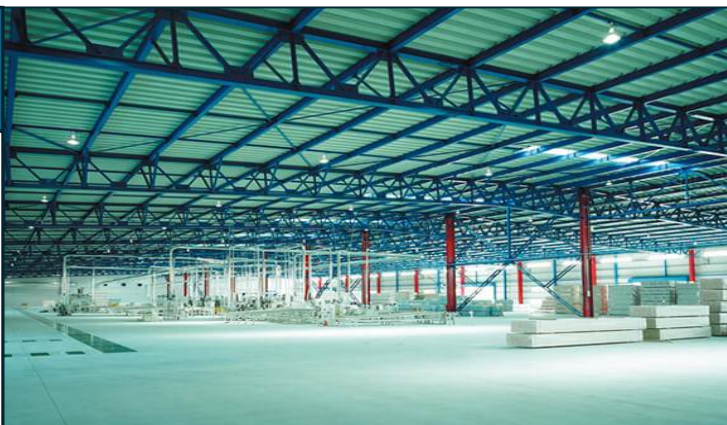
ポラテック西日本(株)滋賀工場 (滋賀県)
