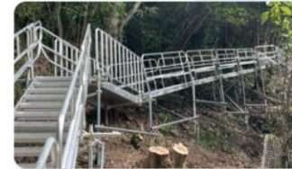
仮設機材 (その他事業)
