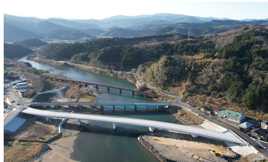
近年の新設橋梁工事例：矢田橋（兵庫県）
