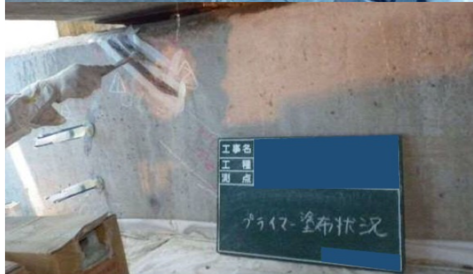
▲躯体補修（ひび割れ注入工法）
